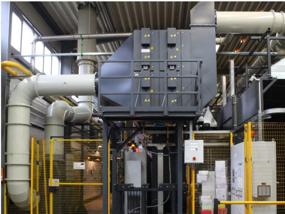
Mit den elektrostatischen Abscheidern wird eine hohe Filterleistung bei geringem Energieverbrauch erreicht (Bild: Büchel).
