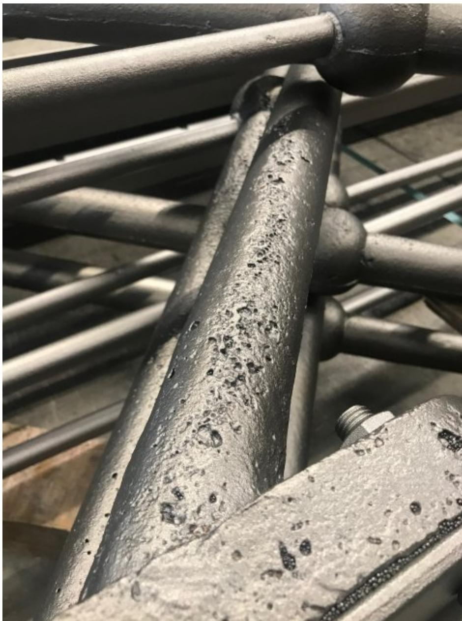
Die betagten Stahlteile des »Eiffelturms des Ruhrgebiets« benötigten den Reinheitsgrad SA 2,5 (Bild: KST).
