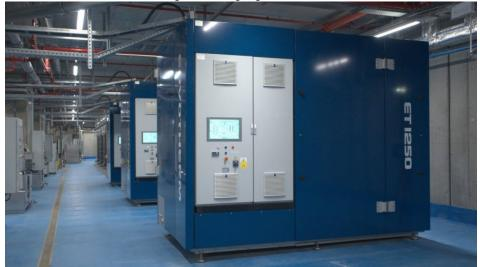
Der energieeffiziente Verdampfer reduziert das Abfallvolumen um bis zu 95 % (Bild: Envotherm).
