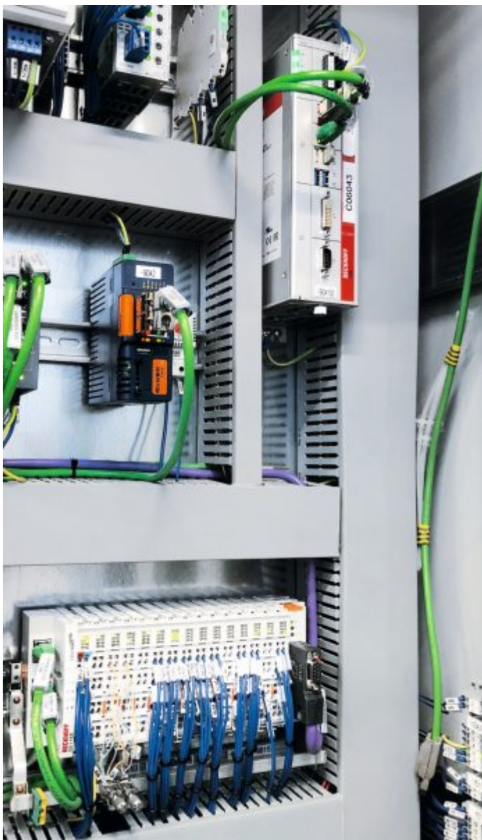
Jeweils ein Industrie-PC (oben) mit »Twincat« sowie verschiedene Ethercat-Klemmen (unten) steuern die Einzelprozesse innerhalb der Pressenstraßen (Bild: Aida Engineering, Japan).
