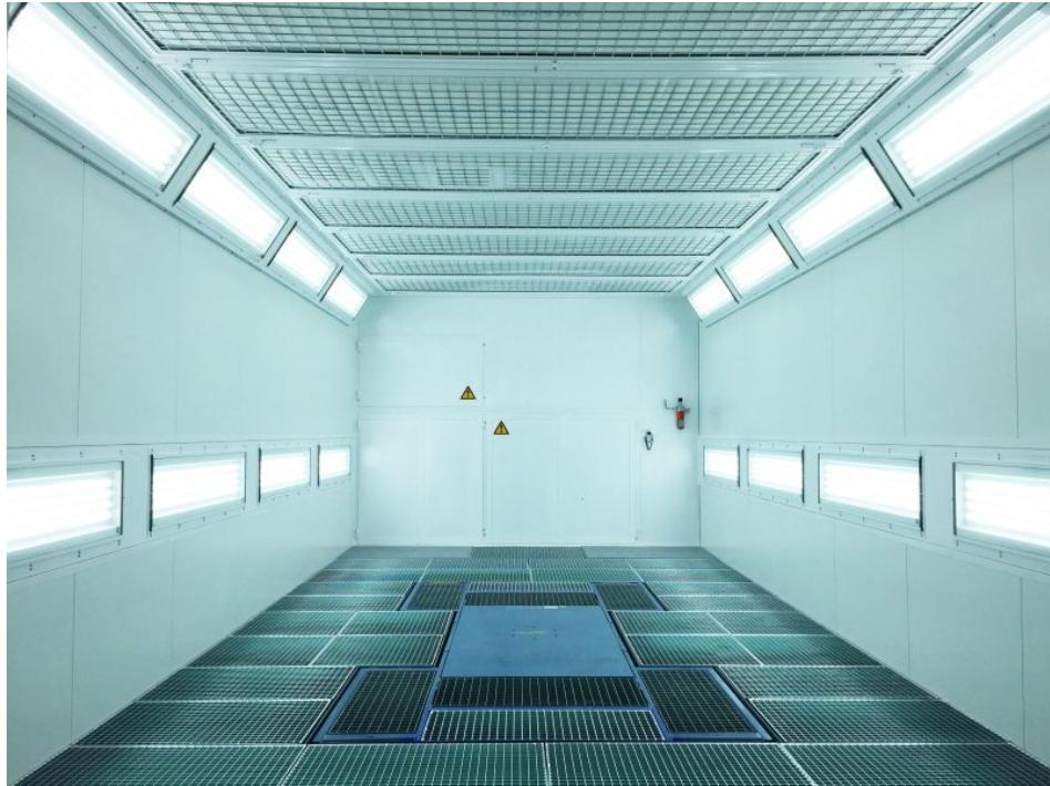
Vorsicht bei Retrofit: Bei Tausch von Leuchtstoffröhren einer Ex-Leuchte durch LED-Röhren droht der Verlust der Ex-Zulassung (Bild: Jung-Leuchten).
