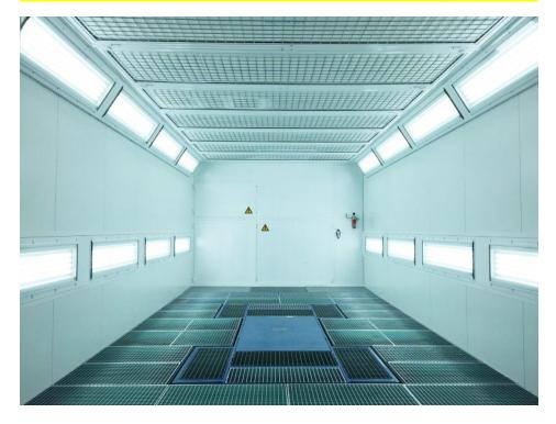
Vorsicht bei Retrofit: Bei Tausch von Leuchtstoffröhren einer Ex-Leuchte durch LED-Röhren droht der Verlust der Ex-Zulassung (Bild: Jung-Leuchten).
