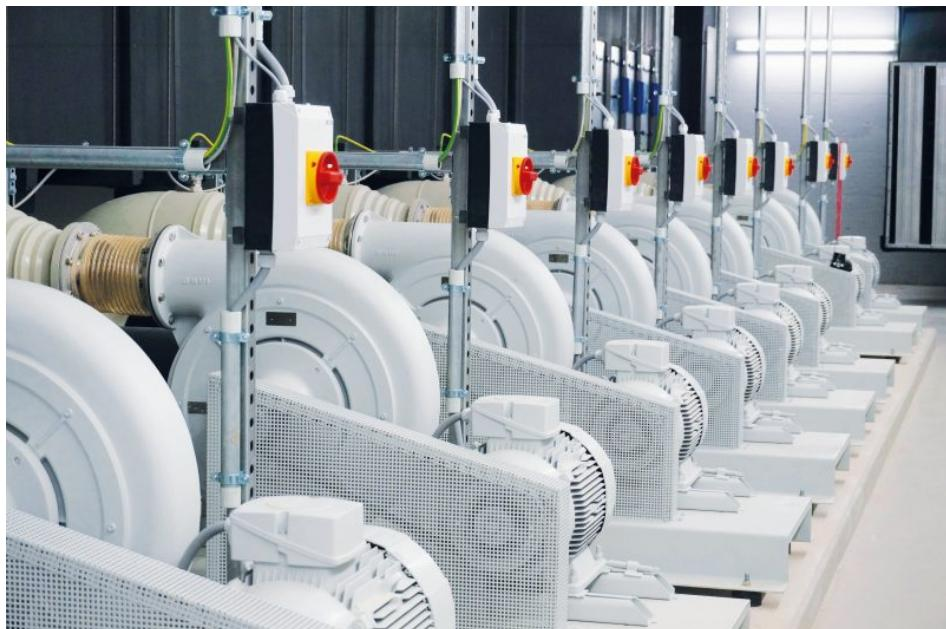
Bei der Trinkwasserentsäuerung kommen Hochdruckventilatoren zum Einsatz (Bild: Aquadosil).
