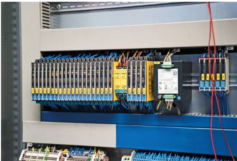
IMX12- und IM36-Verstärker garantieren eine beidseits sichere Signalübertragung im Ex-Umfeld. Bild: Turck
