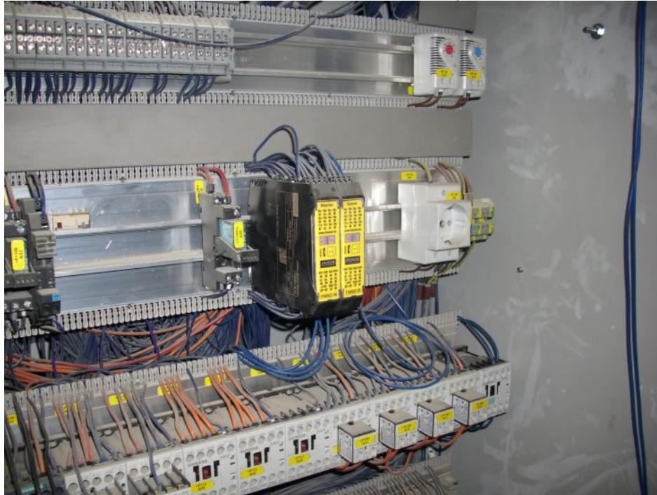
Die Sicherheitssteuerung »FSMC« setzt die Bedingungen für die zeitliche Überbrückung der Lichtgitter. Bild: Fiessler
