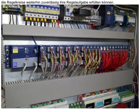
Das Mess-, Regel- und Automatisierungssystem Mtron T von Jumo steuert und regelt sämtliche Kühlprozesse. Bild: Jumo
