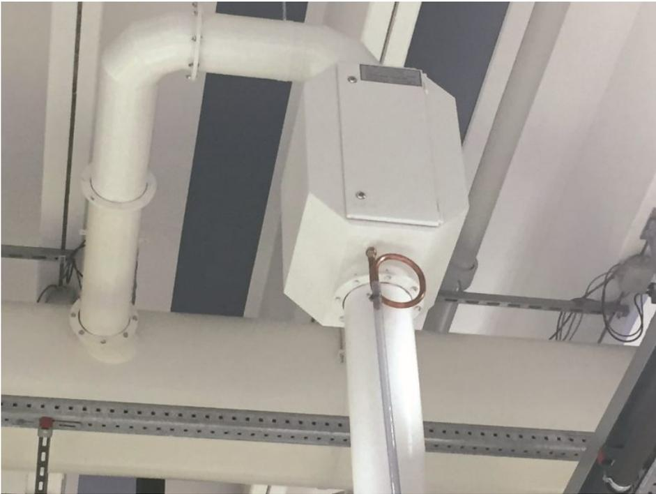
Die Flammensperre von BUECHEL verhindert ohne Elektronik oder Sensorik zuverlässig, dass sich ein Brand über den Maschinenpark ausbreitet.
