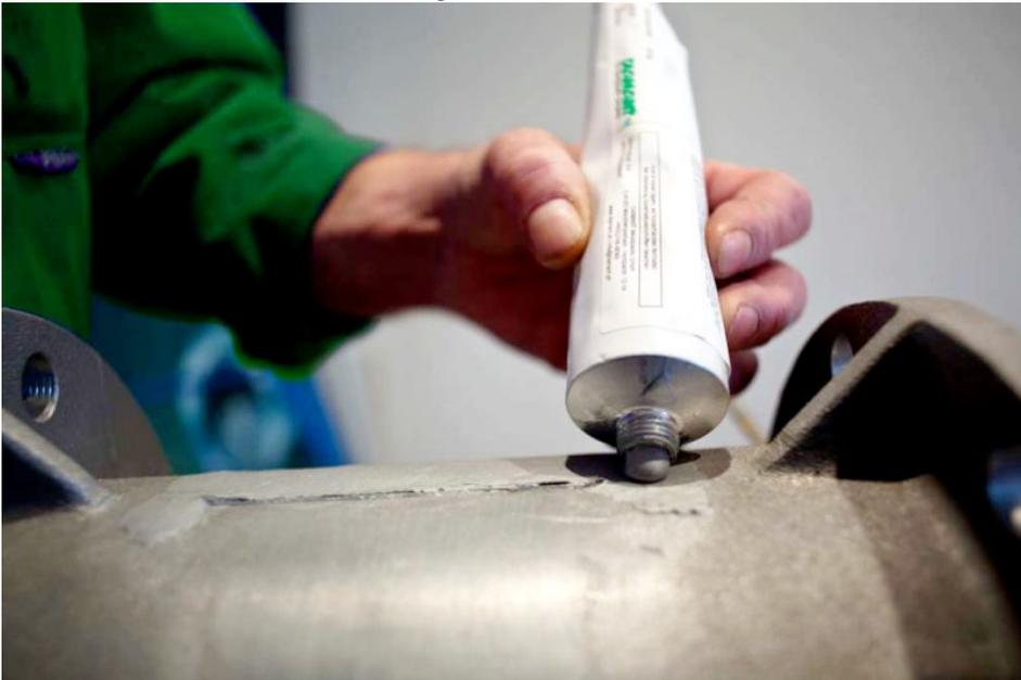
Die Metallreparatur aus der Tube bietet Diamant Metallplastic für schnelle Klein- und Serienreparaturen.
