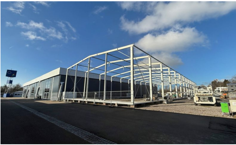
Aufbau Halle E (Bild: SMA).
