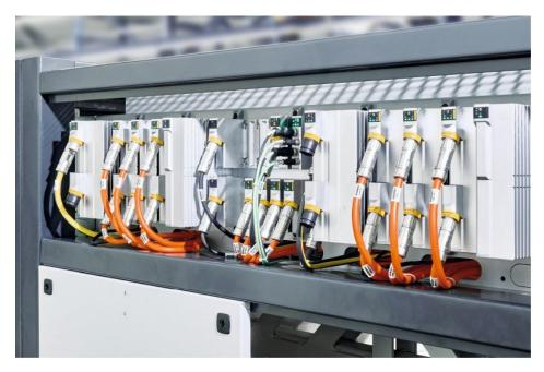
Zweireihige Baseplate der steckbaren Systemlösung für die schaltschranklose Automatisierung: Die offene Montage an den Grundgestellen vereinfacht die Verkabelung der Maschine und erleichtert die Diagnose (Bild: Beckhoff).
