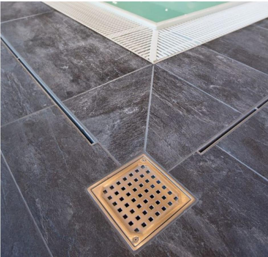
Schrauben statt Schweißen: Modulare Entwässerungssysteme, bei denen die Rinnen mit dem Bodenablauf verschraubt werden, verhindern Spannungsrisse während der Estrichrocknung (Bild: Aschl).
