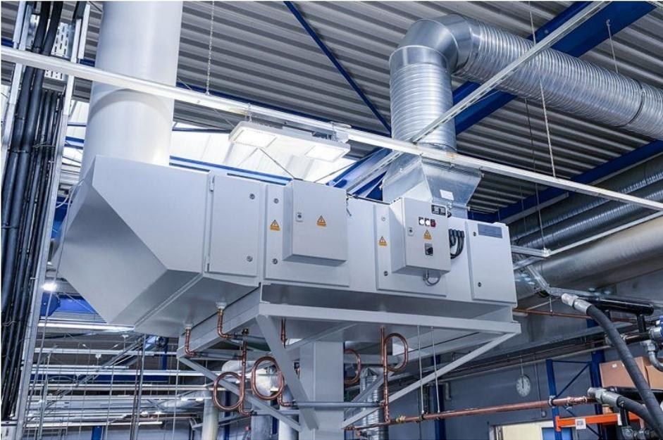
Bei den Absauganlagen kommen – wo immer möglich und technisch sinnvoll – elektrostatische Abscheider zum Einsatz (Bild: Büchel).
