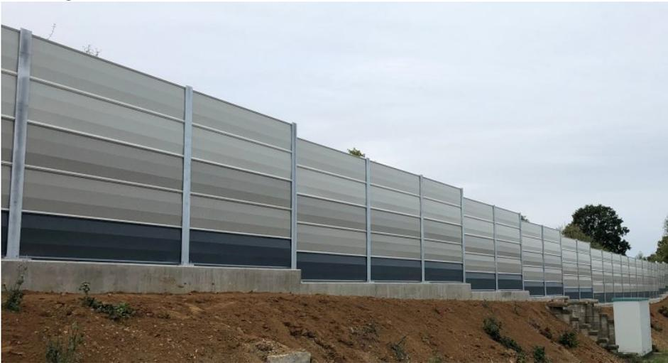
Schallschutzwand in Dudelange mit horizontal überlappenden Aluminiemelementen (Bild: Schäfer Lochblech).
