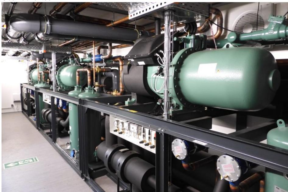
Hocheffiziente Kältemaschinen in Split-Bauweise mit je 450 kW Leistung. Als Medium im Kältekreislauf kommt das Low-GWP-Fluid 513 A zum Einsatz (Bild: L&R).
