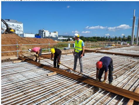
Die Bauarbeiter legen den Bewehrungsstahl, anschließend wird betoniert (Bild: Jumo).
