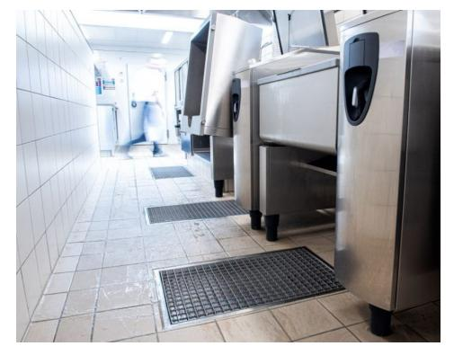
Die Kastenwanne besitzt einen großen Schmutzfangkorb und kann viel Wasser aufnehmen. Die robuste Bodenwanne aus Edelstahl ist sehr belastbar und lässt sich einfach reinigen (Bild: Aschl).
