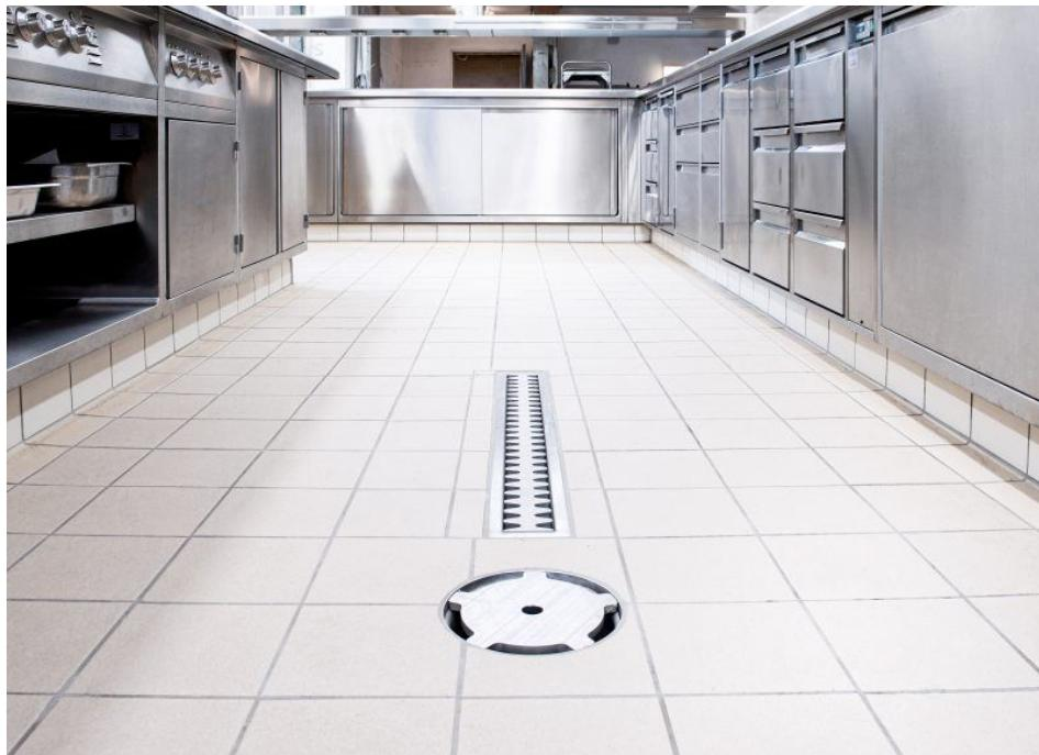
Beispiel für eine Sanierung mit besonders flachem Bodenablauf. Trotz der geringen Aufbauhöhe von 120 Millimetern sorgt dieser für eine hohe Ablaufleistung (Bild: Aschl).
