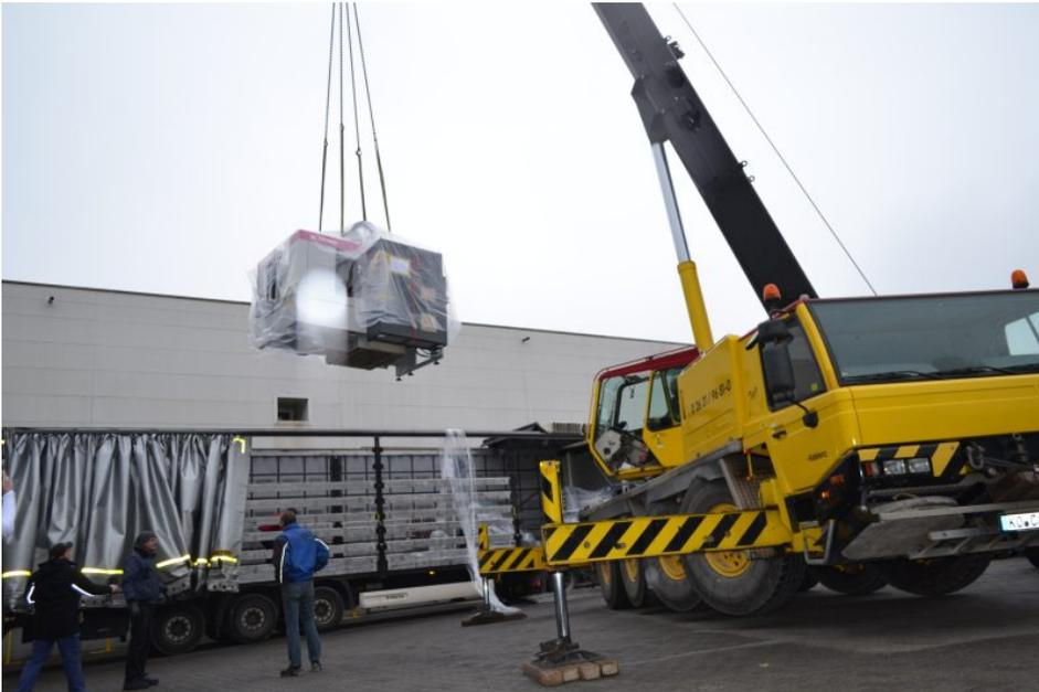
Anlieferung der neuen, ca. 6 t schweren Doppelspindel-Fräsmaschine (Bild: Deloro Wear Solutions).
