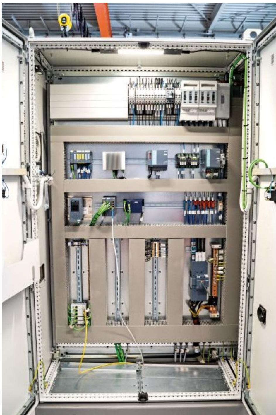
Dank des dezentralen I/O-Konzepts ist im Schaltschrank der modularen Maschine viel Luft (Bild: Turck).
