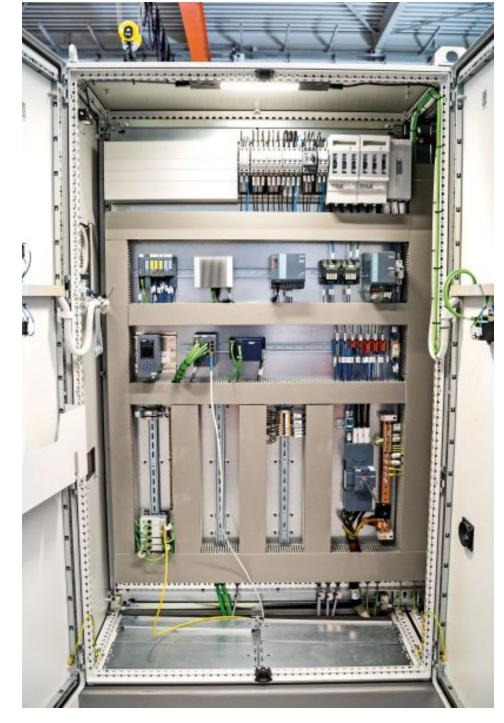
Dank des dezentralen I/O-Konzepts ist im Schaltschrank der modularen Maschine viel Luft (Bild: Turck).
