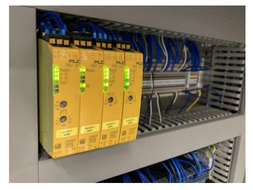
Blick in den Schaltschrank einer aktuellen Maschine: Der kompakte »myPNOZ«-Modulblock wird von Pilz als sofort einsatzbereit geliefert: vormontiert, eingestellt und getestet (Bild: Pilz).
